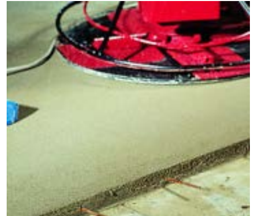
Afwerken van de Topcem dekvloer
