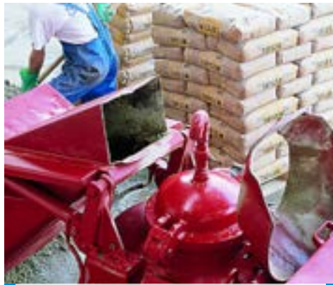
Mengen van Topcem met een automatisch pompsysteem
